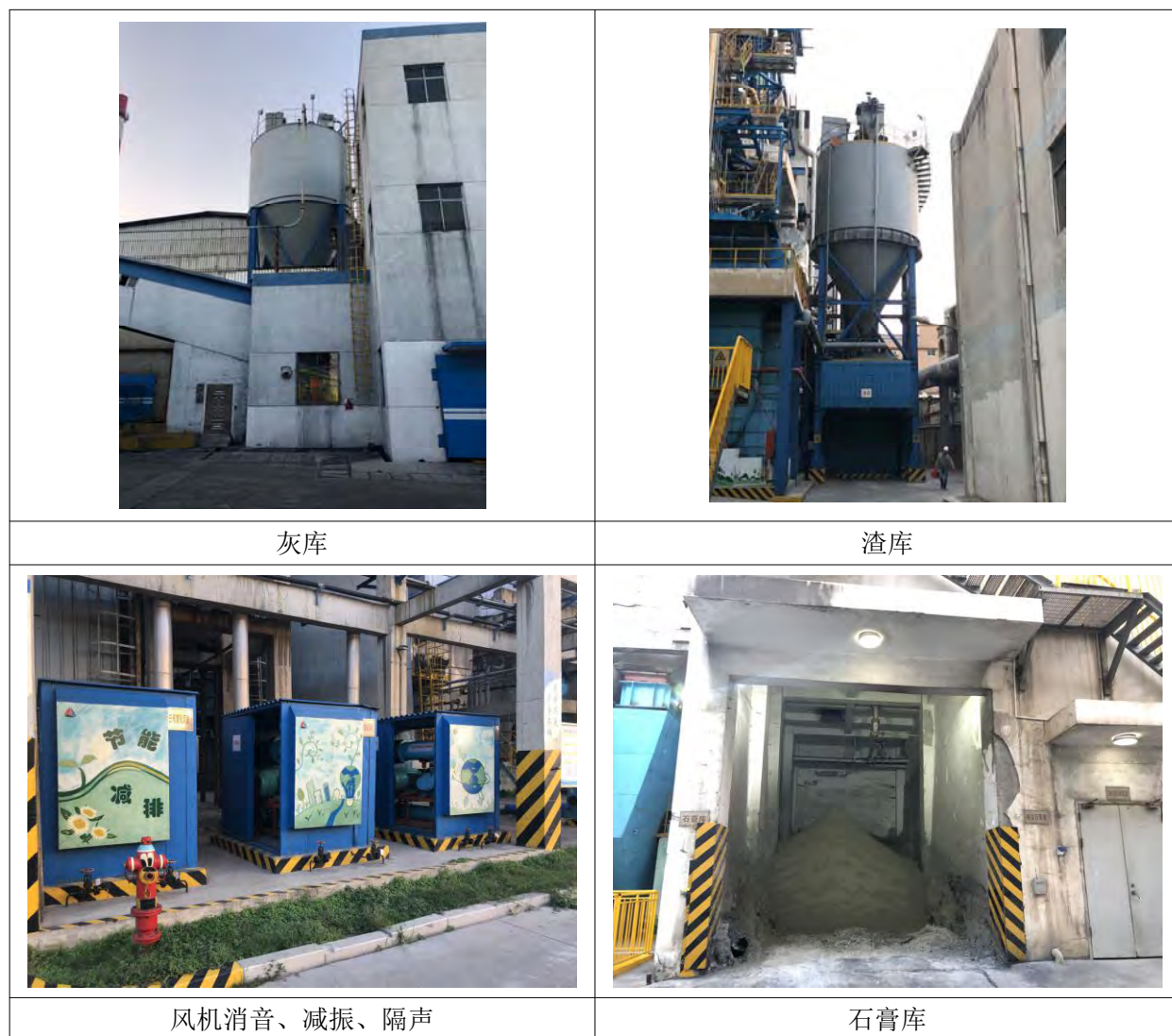
图 2.1-6 现有工程主要建筑物及设施现场照片
