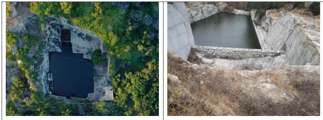
图 3-10 修复区四现状照片
