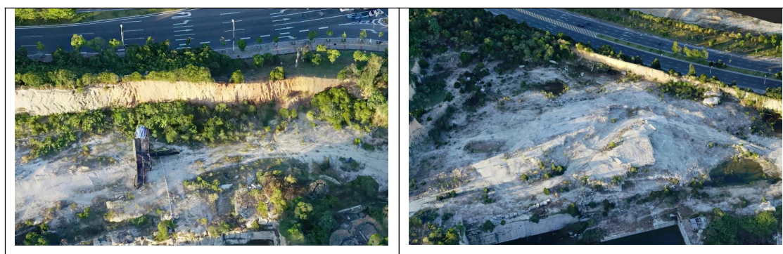
图 3-29 修复区十五现状影像照片
